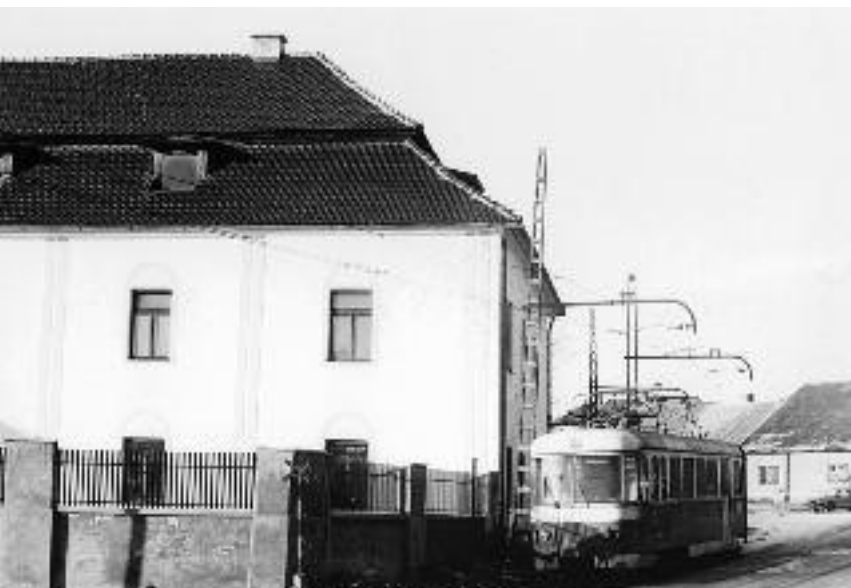
Budova bývalej fary v Poprade-Velkej, od roku 1991 noviciát saleziánov na Slovensku. Spočiatku popri budove ešte jazdila električka do Vysokých Tatier.
